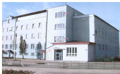
A tak siedziba jednostki wygląda po remoncie.
