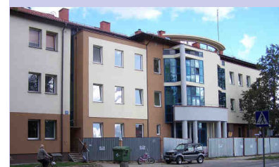
2009r. - budowa nowej siedziby KPP w Szczycinie.
