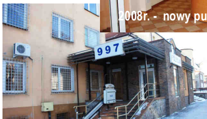
2008r. - siedziba KPP w Elku po remoncie.
